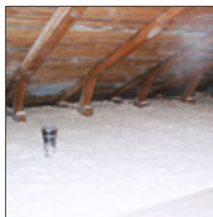
Efter tilläggsisolering med träfiber. Klart!
